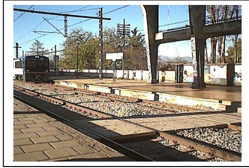
Pasos peatonal en buenas condiciones
